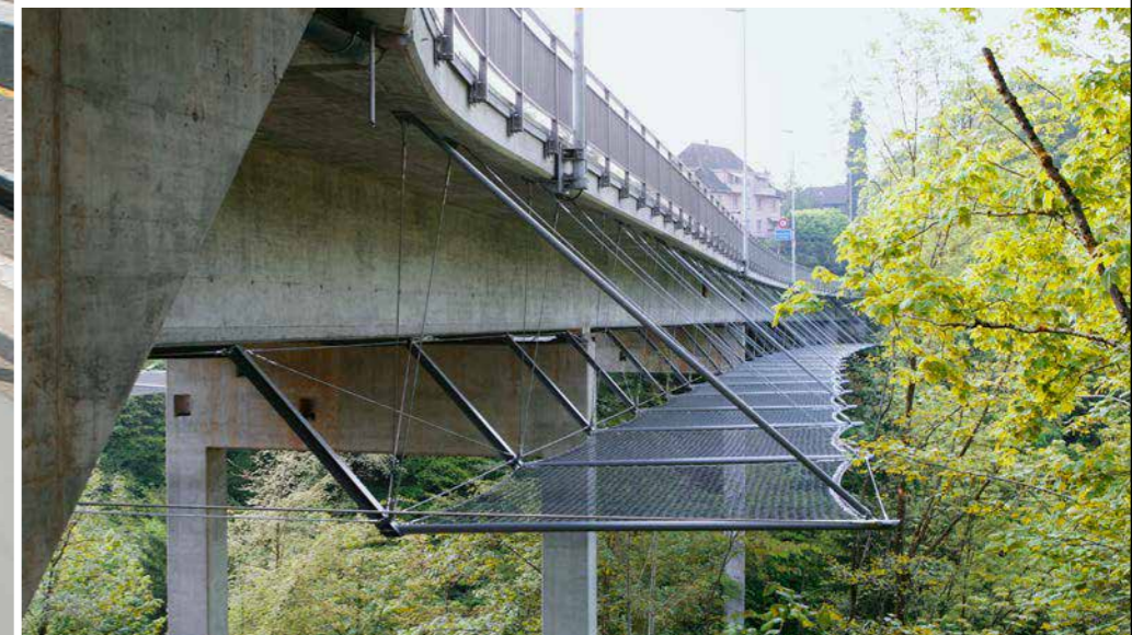
Rotbachbrücke, Rothenburg (CH)
